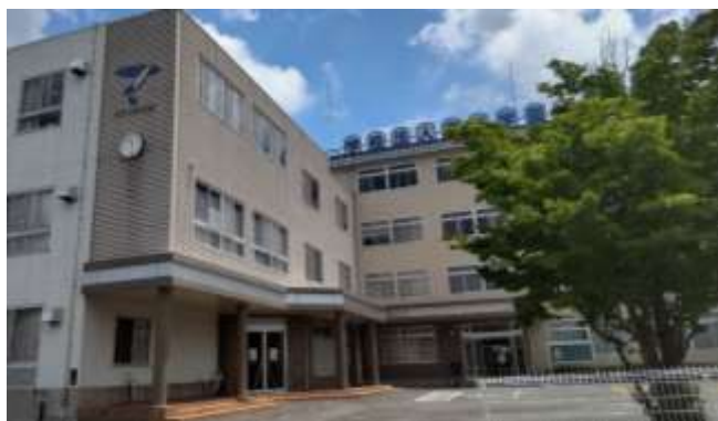
【図Ⅲ-B-1-1】正面玄関スロープ
