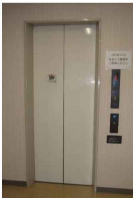
【図Ⅲ-B-1-3】エレベーター
