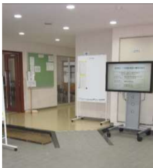
【図Ⅲ-B-1-2】1階室内スロープ
